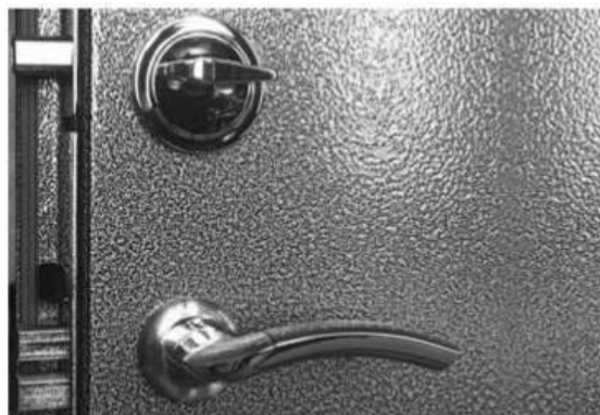
Рис. 2.8. Фрагмент металлической двери с порошковым напылением
