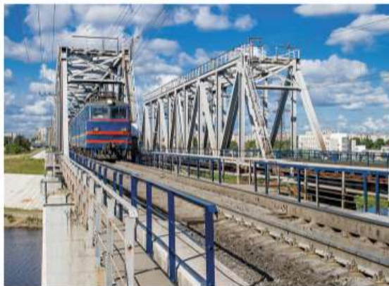
Рис. 5.5. Образец применения профилей металла в конструкции железнодорожного моста
