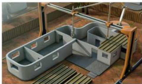
Рис. 2.14. Применение 3D-принтеров в строительстве
